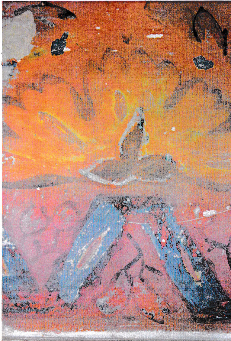
Befund, Malschichtverluste durch Ablaugen der Oberfläche
